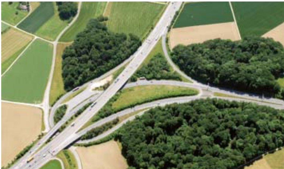
A 2 Ein Autobahndreieck zerteilt ein Gebiet in mehrere kleinere Lebensräume. Autobahnen sind in der Schweiz für viele Wildtiere unpassierbar, da sie eingezäunt sind (Foto: Kantonsarchäologie, Zürich).
